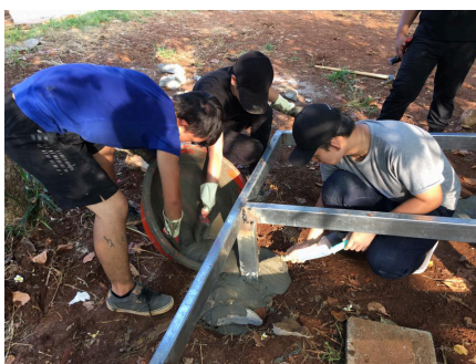
建築系同學混和水泥進行灌漿作業
